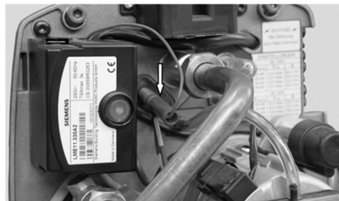
Abb. 19: Steckverbindung Ionisationselektrode
