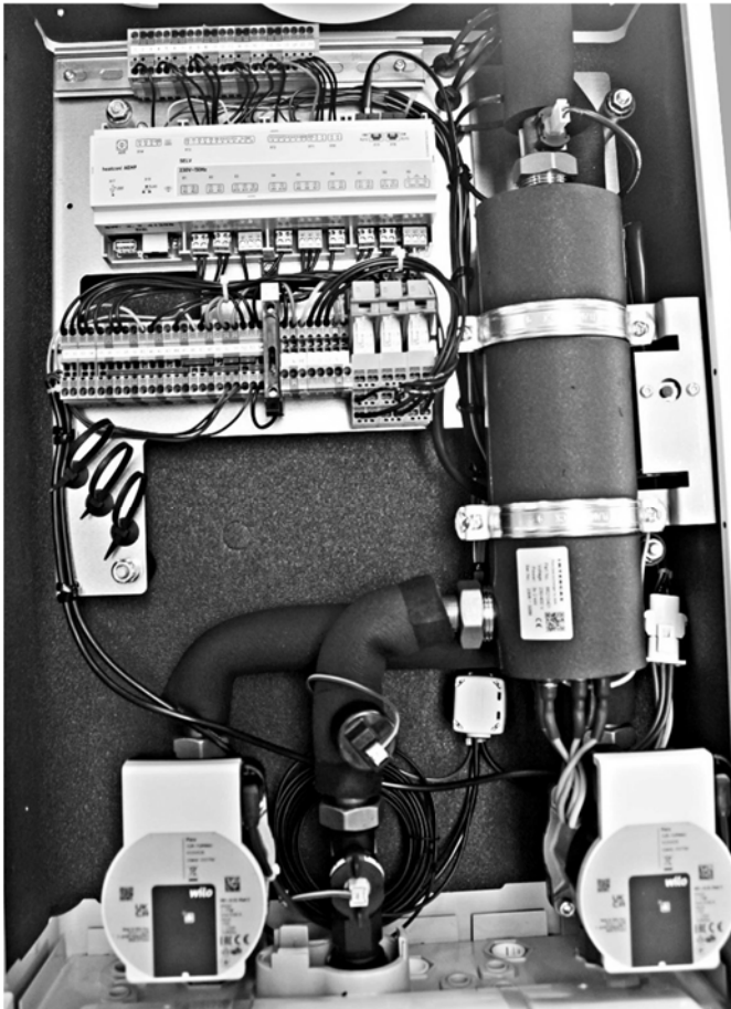
Abb. 76: Anschlussklemmen Regelungseinheit
