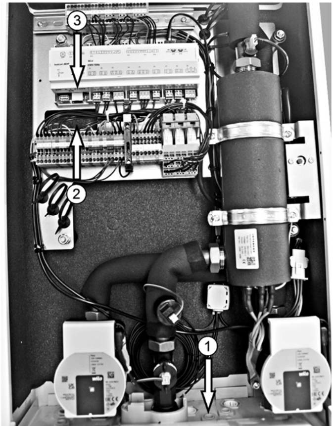
Abb. 45: Anschluss Ethernet-Leitung
