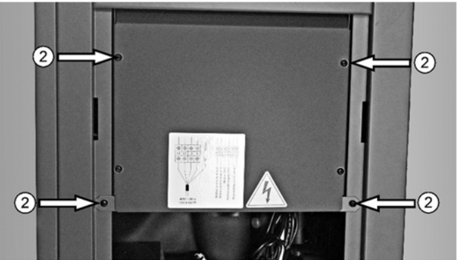
Abb. 33: Befestigungsschrauben ② von der Abdeckung der Anschlussklemmen
