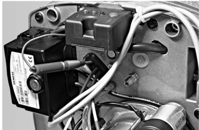
Abb. 19: Steckverbindung Ionisationselektrode
