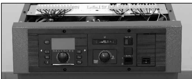
Abb. 32: THETA+ Regelung mit zwei Schrauben befestigen.
