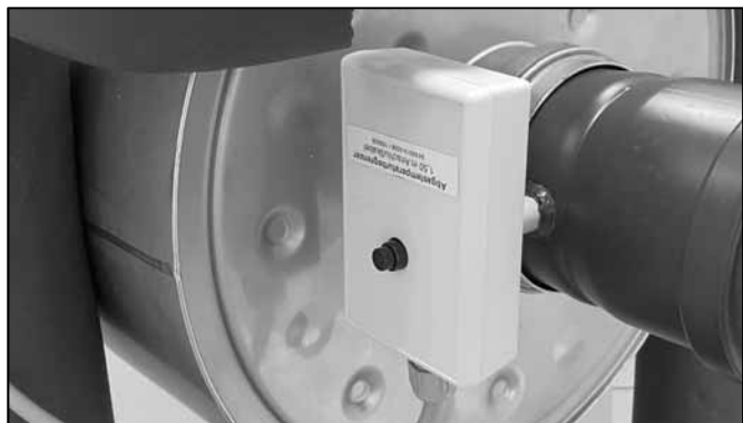
Abb. 88: Position des ATB DN80 (gesteckt)
