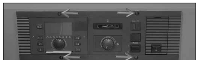
Abb. 35: Befestigungsschrauben des Kesselschaltfeldes
