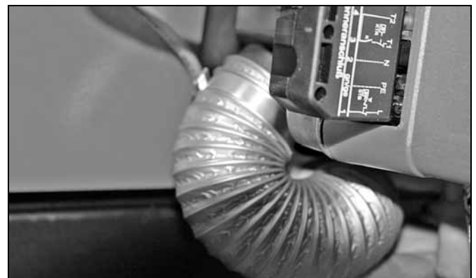
Abb. 21: Montage des RLU-Zuluftschlauchs
