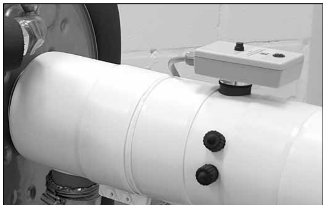
Abb. 89: Position des ATB DN80/125 (geschraubt oder gesteckt, ausführungsabhängig)
