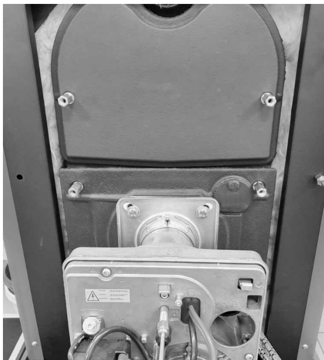
Abb. 85: Obere und untere Kesseltür
