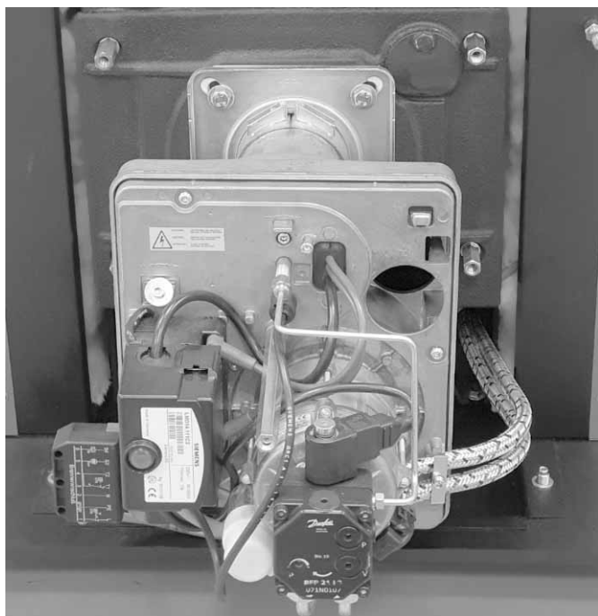
Abb. 7: Montierter Öl-Blau-Brenner
