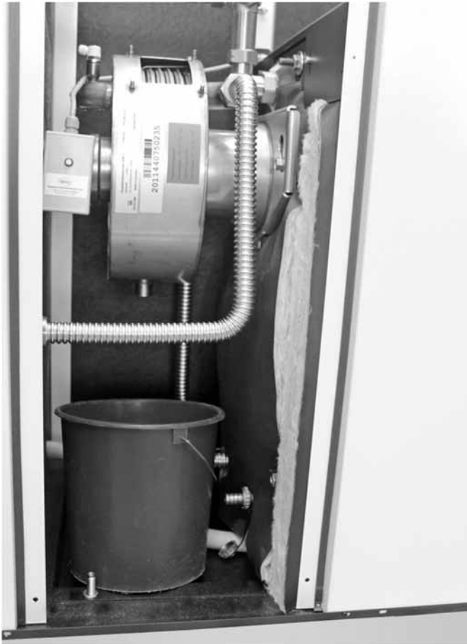
Abb. 90: Zur Reinigung vorbereiteter RWT
