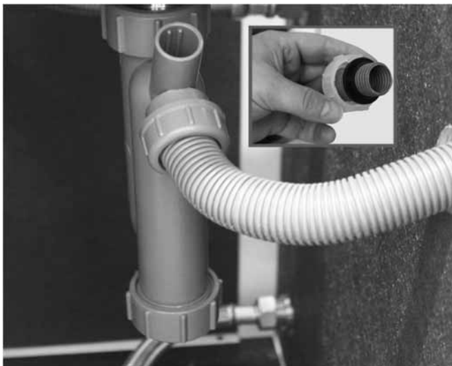
Abb. 16: Montage des Kondensatschlauchs
