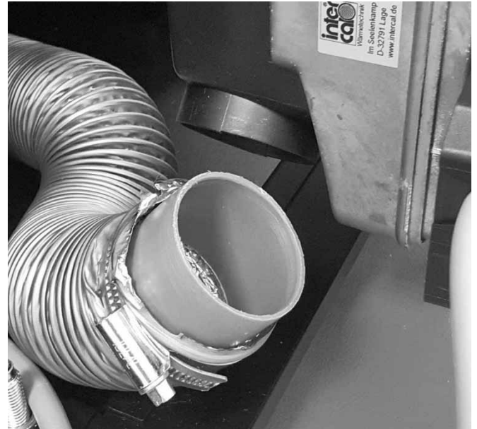
Abb. 13: Zuluftschlauch mit 50 mm Anschluss-Stück
