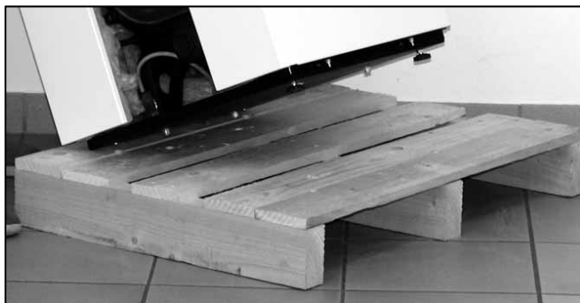
Abb. 6: Montage der Kesselfüße
