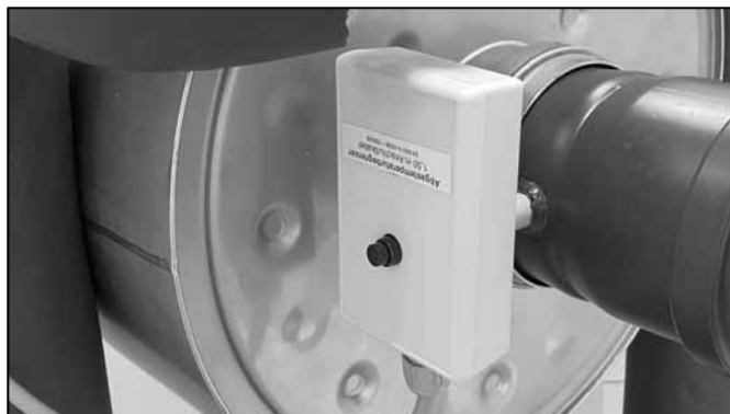
Abb. 88: Position des ATB DN80 (gesteckt)
