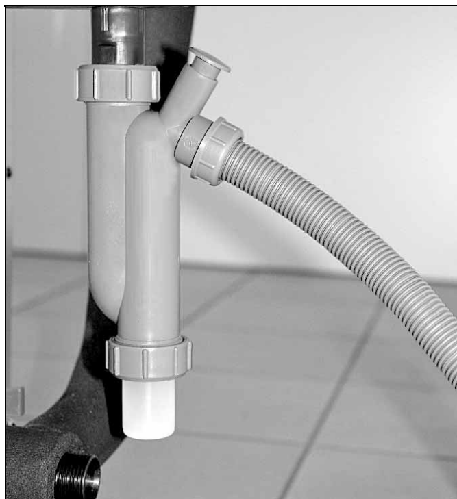
Abb. 23: Montierter Kondensatschlauch am Siphon
