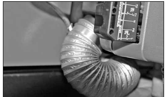
Abb. 21: Montage des RLU-Zuluftschlauchs
