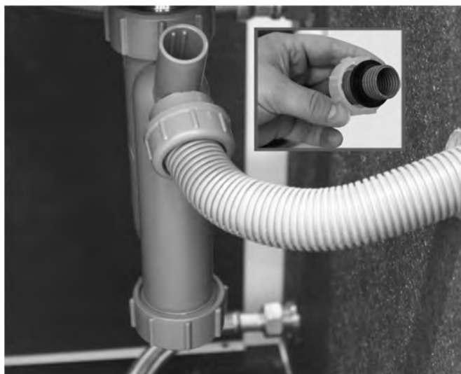
Abb. 16: Montage des Kondensatschlauchs
