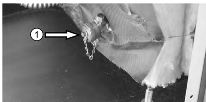
Abb. 23: Entleerhahn ① im Kessel
