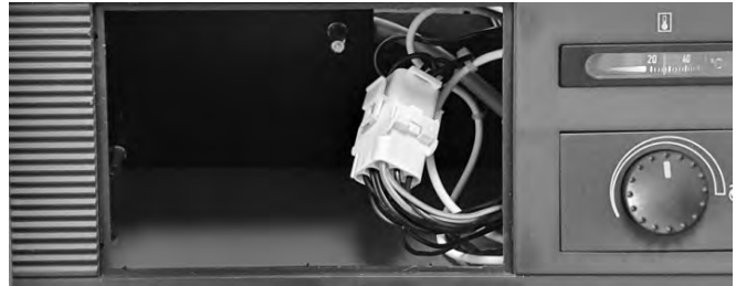
Abb. 106: Aufgesteckter Brückenstecker.
