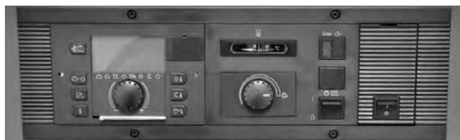
Abb. 36: Montierte THETA+ im Kessel-Grundschaftfeld.
