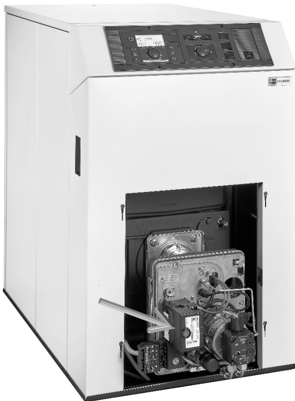
Abb. 2: Reset-Taste am Brenner BNR 100
