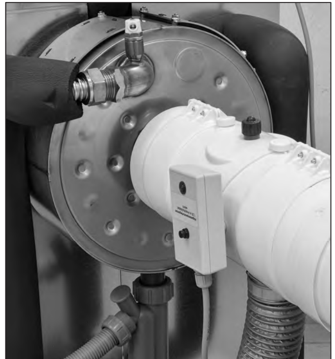
Abb. 15: Montierter Kessel-Anschluss DN80/125 mit Zuluftschauch.
