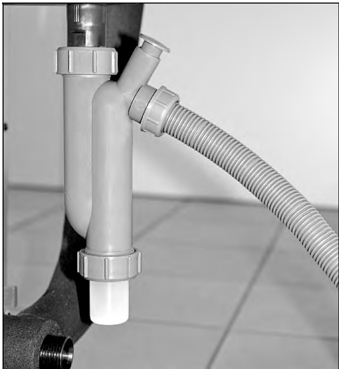
Abb. 23: Montierter Kondensatschlauch am Siphon
