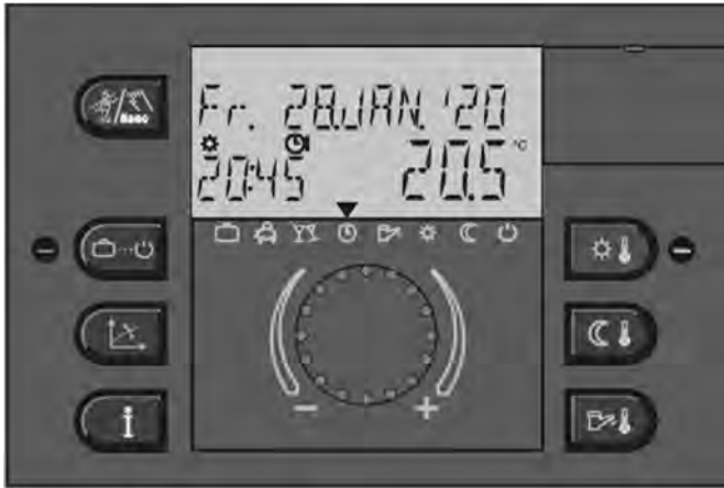
Abb. 79: Bedienfeld der Kesselregelung THETA+
