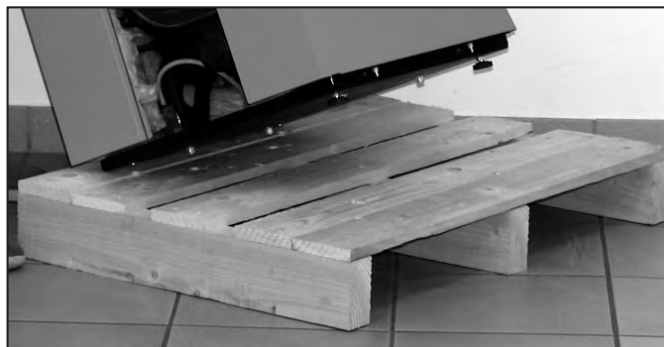
Abb. 6: Montage der Kesselfüße
