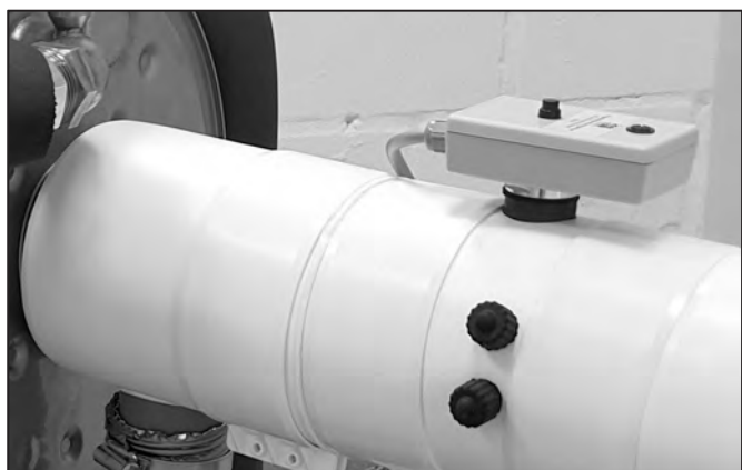
Abb. 89: Position des ATB DN80/125 (geschraubt oder gesteckt, ausführungabhängig)
