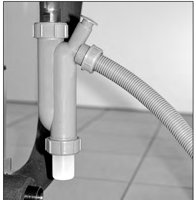
Abb. 80: Siphon und Kondensatschlauch
