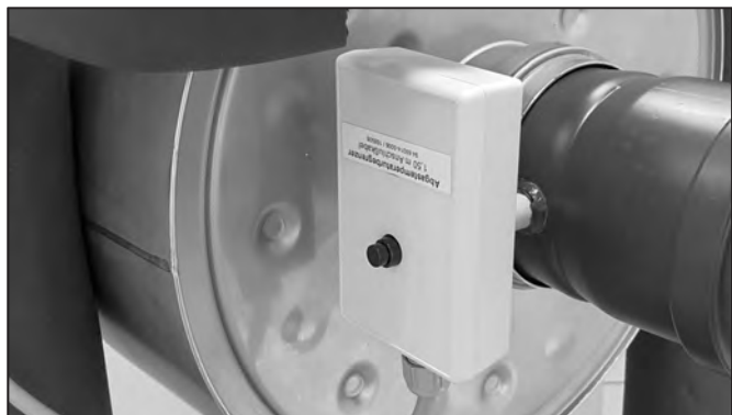
Abb. 88: Position des ATB DN80 (gesteckt)
