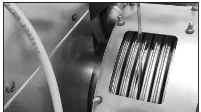
Abb. 87: Anwendung der Reinigungsklinge
