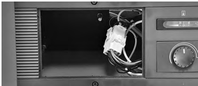
Abb. 105: Aufgesteckter Brückenstecker.
