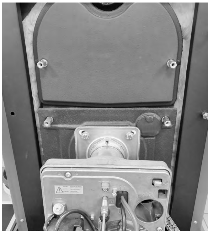
Abb. 84: Obere und untere Kesseltür
