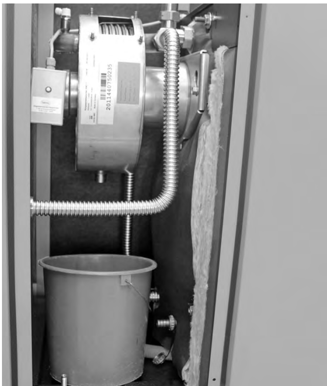
Abb. 89: Zur Reinigung vorbereiteter RWT
