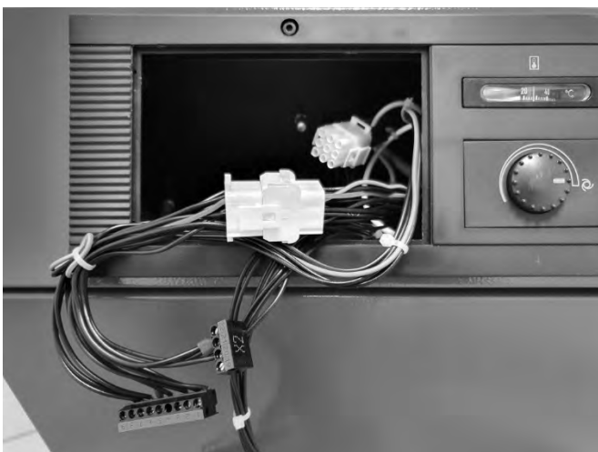
Abb. 33: Anschlussstecker für den Regler.
