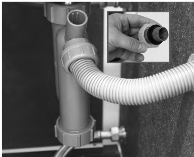
Abb. 16: Montage des Kondensatschlauchs
