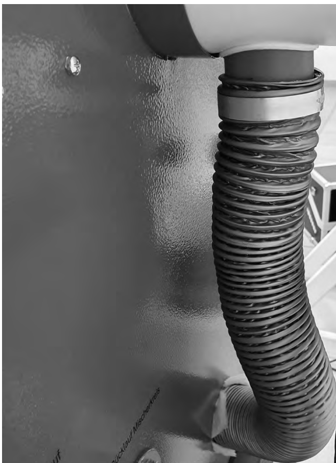
Abb. 12: Zuluftschlauch am Kesselabgasanschluss
