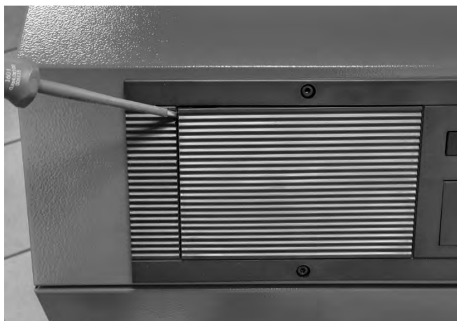
Abb. 28: Demontage der Blindabdeckung
