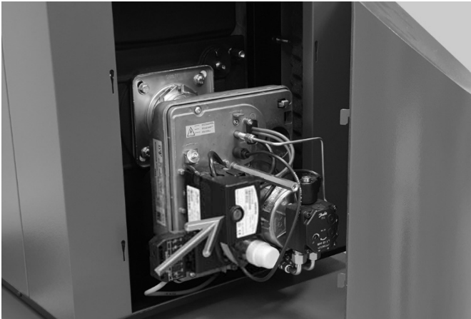
Abb. 2: Reset-Taste am Brenner BNR 100
