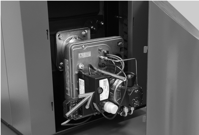
Abb. 2: Reset-Taste am Brenner BNR 100
