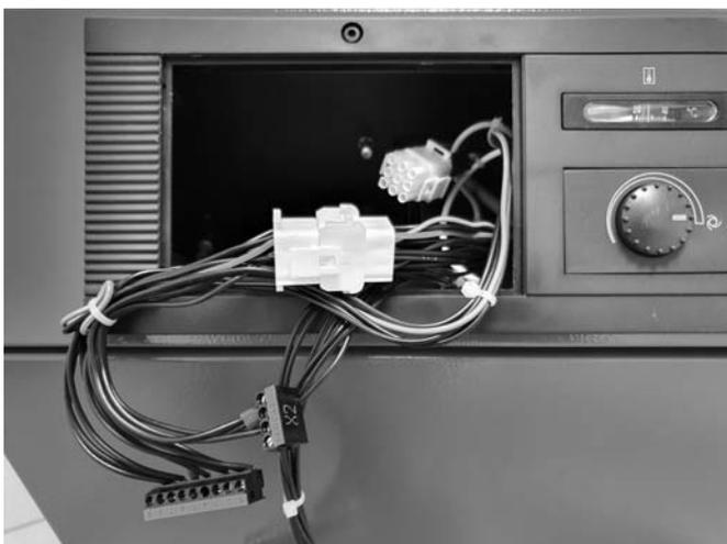
Abb. 33: Anschlussstecker für den Regler.
