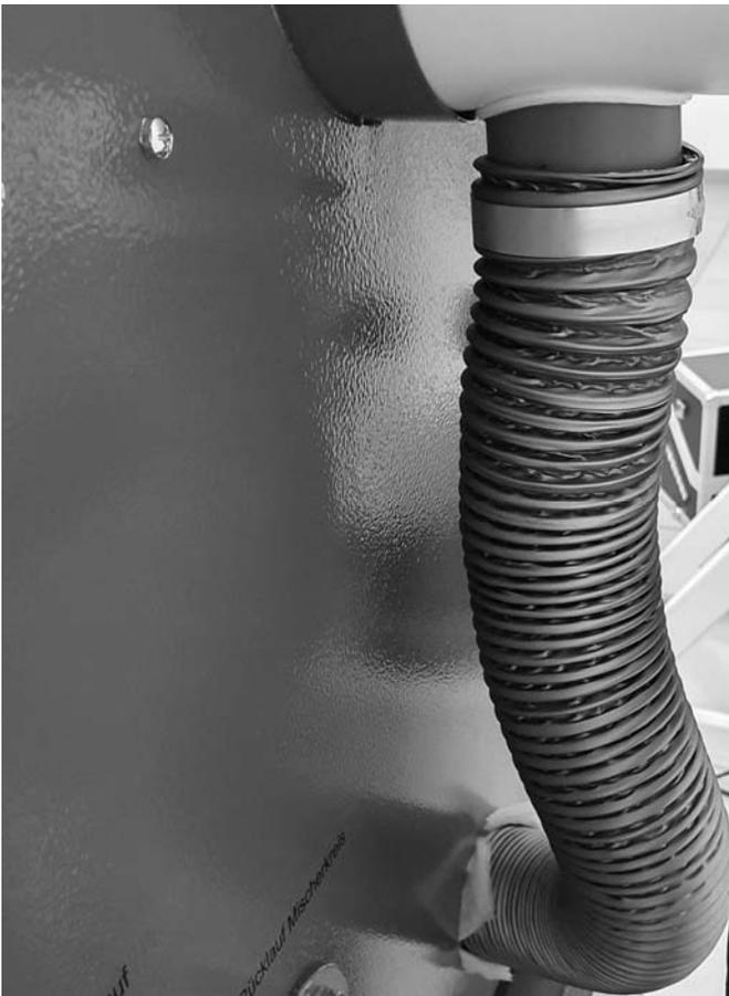
Abb. 12: Zuluftschlauch am Kesselabgasanschluss
