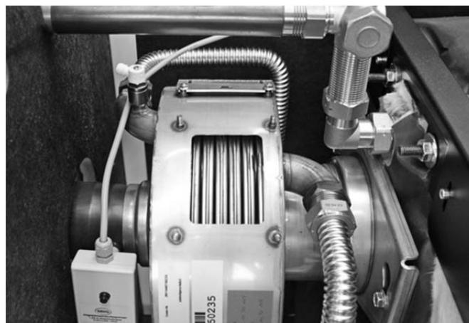
Abb. 88: Reinigungsöffnung des RWT
