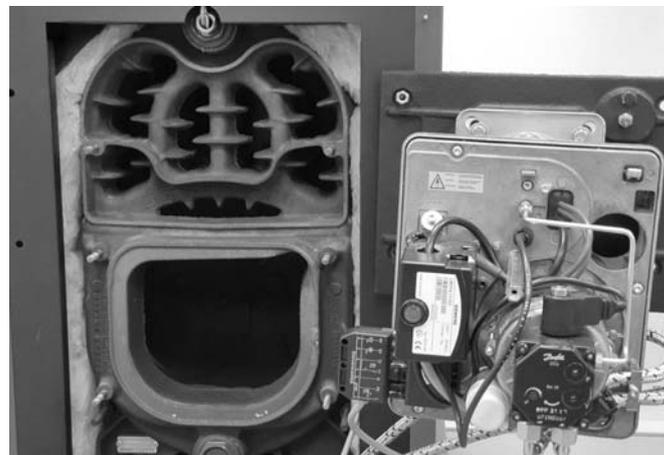
Abb. 85: Geöffneter Kessel mit Brenner in Serviceposition.
