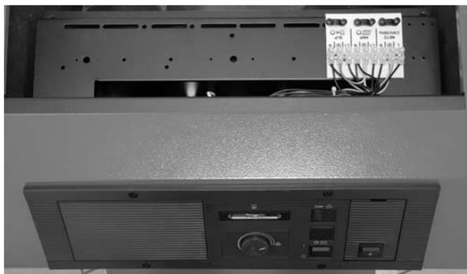
Abb. 27: Kessel-Grundschaltfeld ohne Regelung und Montagebereich für Anschluss-Klemmbrett
