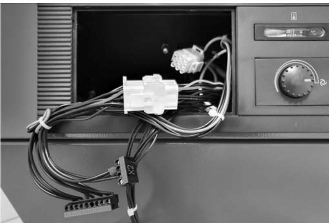
Abb. 104: Getrennte Anschlussstecker für den Regler.
