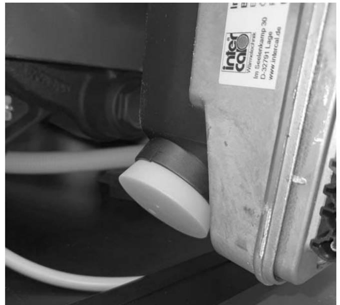
Abb. 8: Zuluftstopfen im Ansaugschalldämpfer
