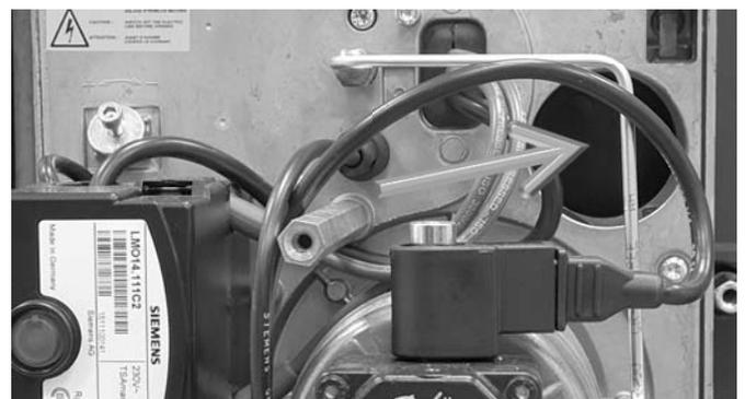
Abb. 9: Luft-Ansaugöffnung des Brenners BNR 100
