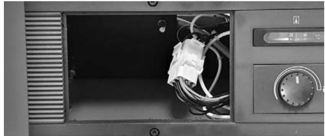
Abb. 105: Aufgesteckter Brückenstecker.
