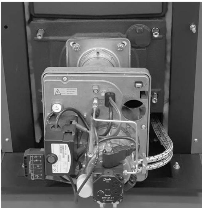
Abb. 7: Montierter Öl-Blau-Brenner
