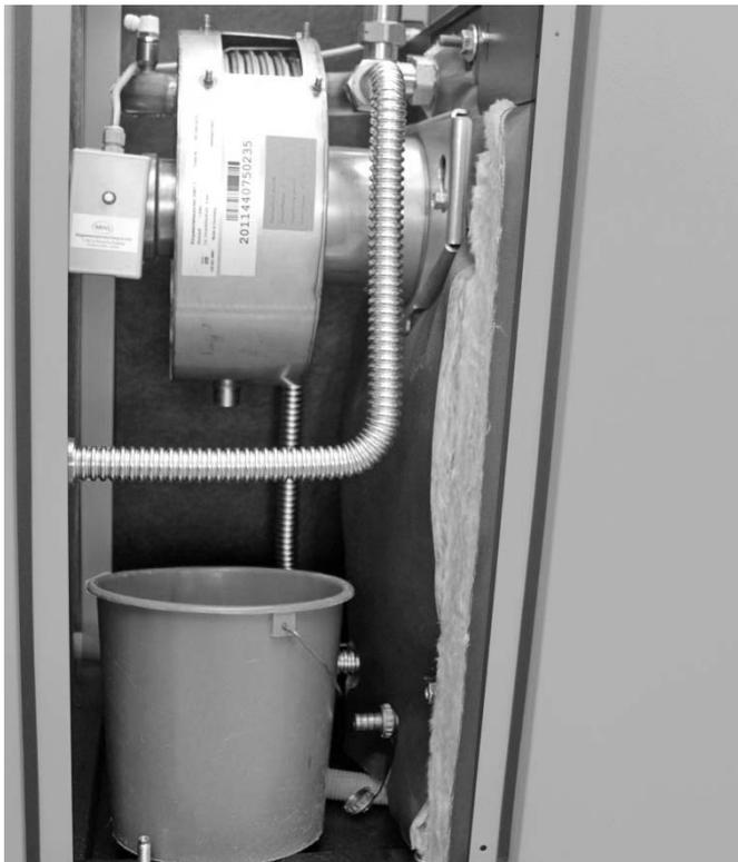
Abb. 89: Zur Reinigung vorbereiteter RWT
