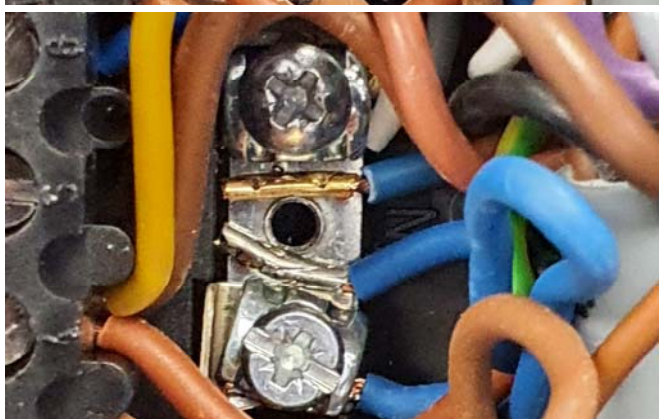
Abb. 11: Freigelegte Stützpunktklemme 31
