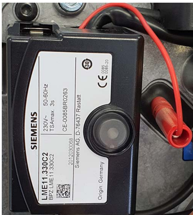
Abb. 20: Aufgesteckter Feuerungsautomat.
