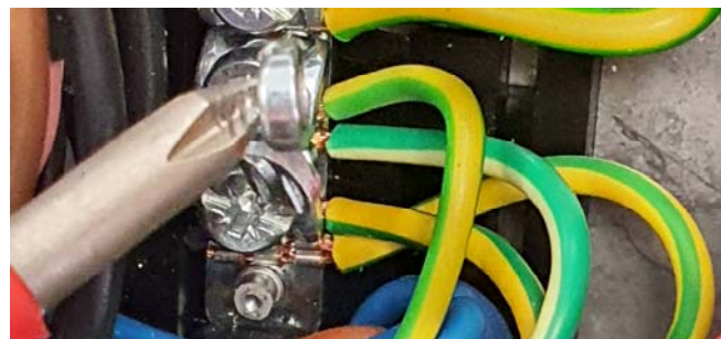
Abb. 14: Schadhafte Klemme
