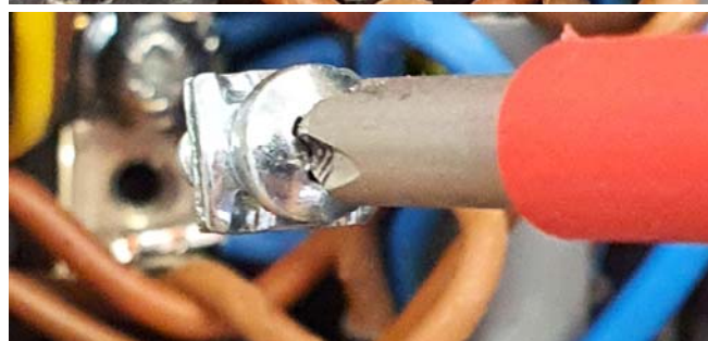
Abb. 10: Verfahrensweise Neutraleiter-Klemmentausch
