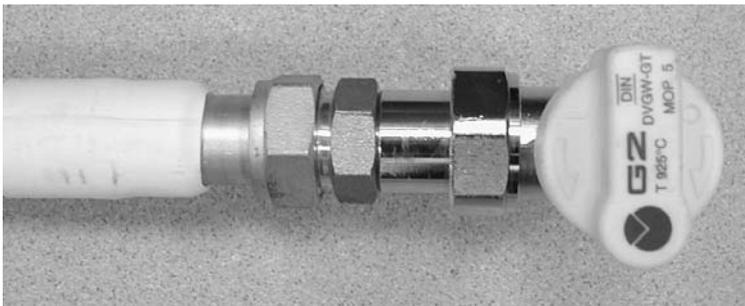
Abb. 10: Erst dann die Verbindung zur Gasversorgung herstellen.
