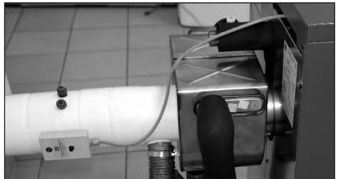
Abb. 104: Abgaswärmetauscher mit Anschluss DN80/125 und Kesselanschluss mit Abgastemperaturbegrenzer DN80/125.
