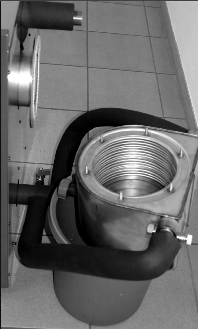
Abb. 132: Hydraulikanschlüsse brauchen dabei nicht gelöst werden. Es wird empfohlen, den Wärmetauscher mit einem alkalischen Edelstahlreiniger z.B. SOTIN 300 zu behandeln.
