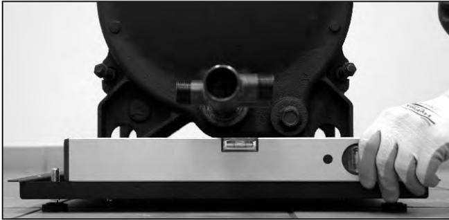
Abb. 27: Bodenplatte ausrichten
