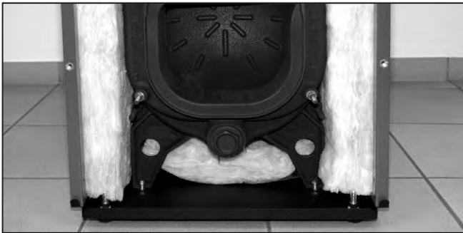
Abb. 56: Bodendämmung einlegen.
