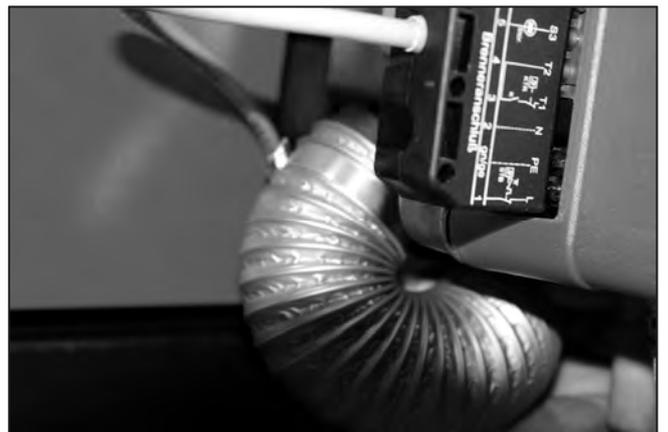
Abb. 105: Zuluftschlauch am Brenner anschließen.
