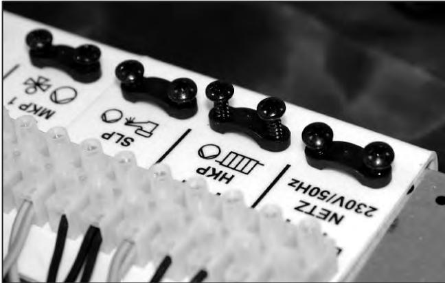
Abb. 82: Zugentlastungen verwenden.
