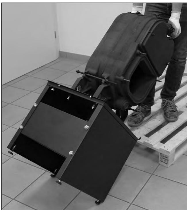
Abb. 21: Aufrichten des Kessels mit Kesselsockel.
