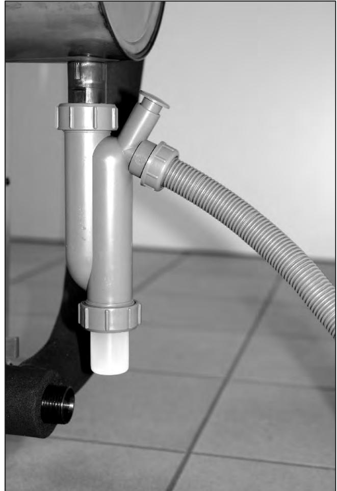
Abb. 130: Siphon und Kondensatleitung demontieren und spülen.
