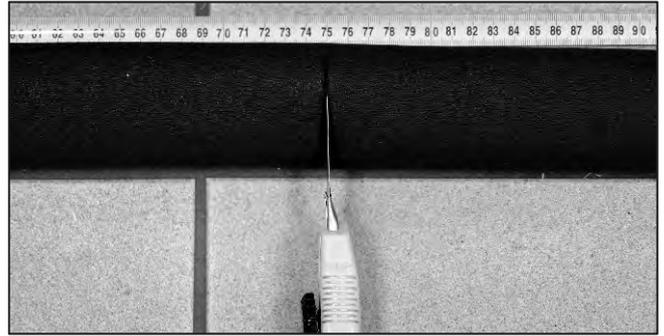
Abb. 41: Beide Rohrisolierungen (1m) im Verhältnis 75 cm zu 25 cm aufteilen.
