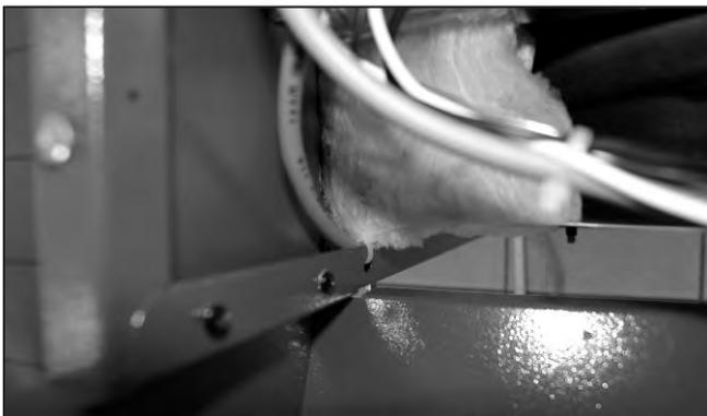
Abb. 78: Brennerkabel auch oben in dem Seitenfalz unterhalb des Schaltfeldes mit einem Kabelbinder sichern.
