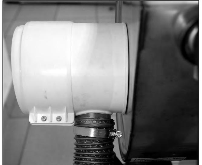
Abb. 103: Anschluss DN80/125 aufstecken und den Zuluftschlauch mit der Bandschelle befestigen.
