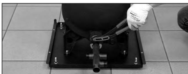
Abb. 25: Rücklaufverteiler einschrauben. Die Gewindedemuffe für das KFE-Ventil muss zum Schluss nach rechts zeigen.
