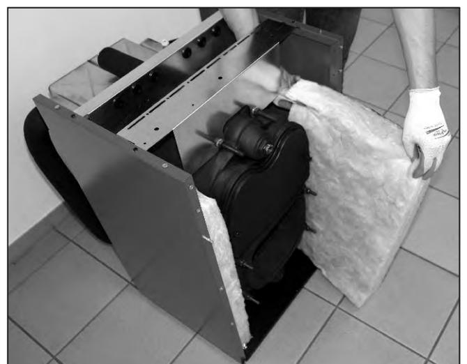
Abb. 55: Seitendämmung einziehen.
