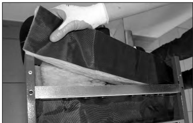
Abb. 61: Obere schmale Isolierung auf die Rückwandisolierung auflegen.
