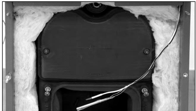
Abb. 73: Kapillarrohre seitlich neben dem Schutzblech nach unten stecken.
