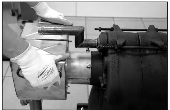
Abb. 31: Abgaswärmetauscher fest auf den Abgasstutzen des Kessels schieben.
