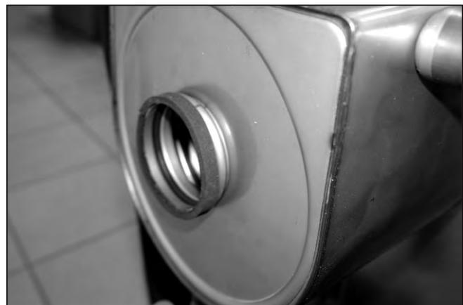
Abb. 100: Moosgummidichtung um die Muffe des Wärmetauschers kleben.
