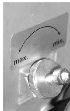
Durch die Verstellung der Luftklappe wird die Verbrennungsluft an die Ölmenge (Leistung) angepasst.
