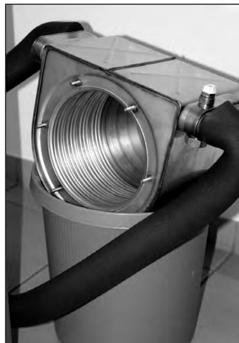
Abb. 131: Wärmetauscher vom Flansch lösen und z.B. auf einem Eimer ablegen. So lässt er sich einfach aussaugen und spülen.
