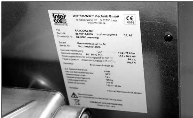
Abb. 97: Kesseltypenschild auf Rückwand aufkleben
