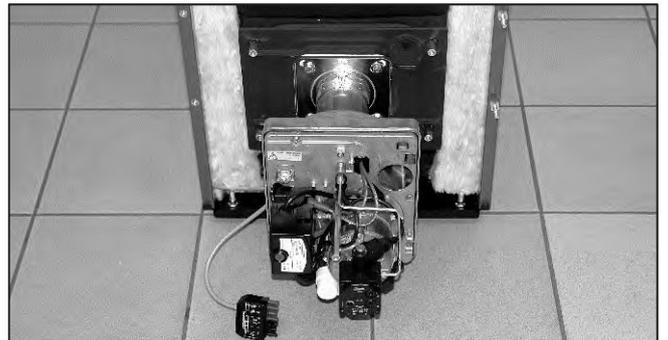
Abb. 93: Brenner wieder montieren.
