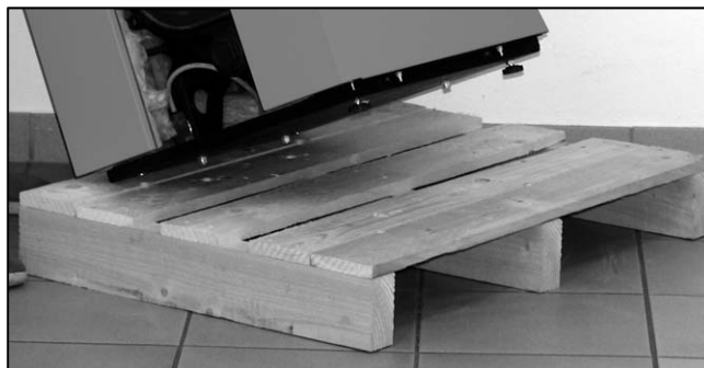
Abb. 6: Montage der Kesselfüße
