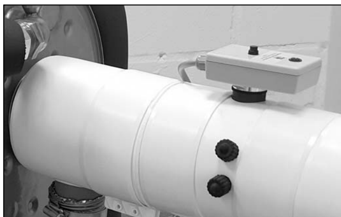
Abb. 91: Position des ATB DN 80/125 (geschraubt)
