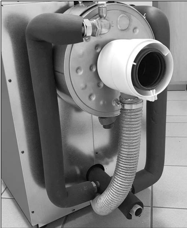
Abb. 16: Montierter Anschluss DN 80/125
