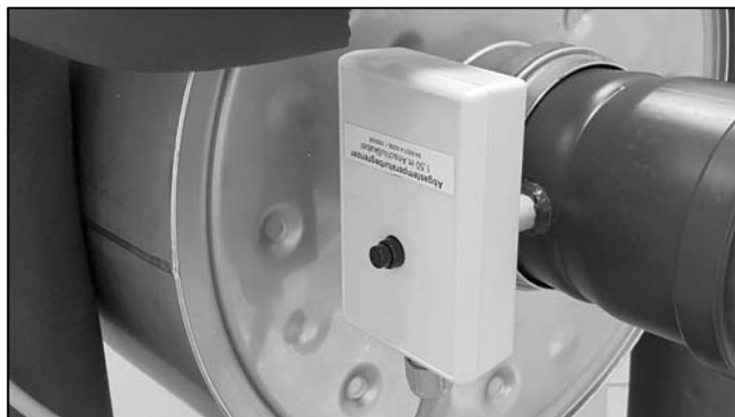
Abb. 90: Position des ATB DN 80 (gesteckt)
