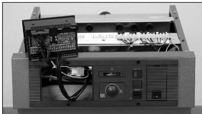
Abb. 33: Reglerkabelsatz in den Steckverbinder stecken, Anschlussklemmen am Regler aufstecken und Anschlussklemmenwinkel auf der Traverse einclippen. Kesselfühler parallel zu den Kapillarrohrfühlern verlegen und auch tief in die Tauchhülse einführen.
