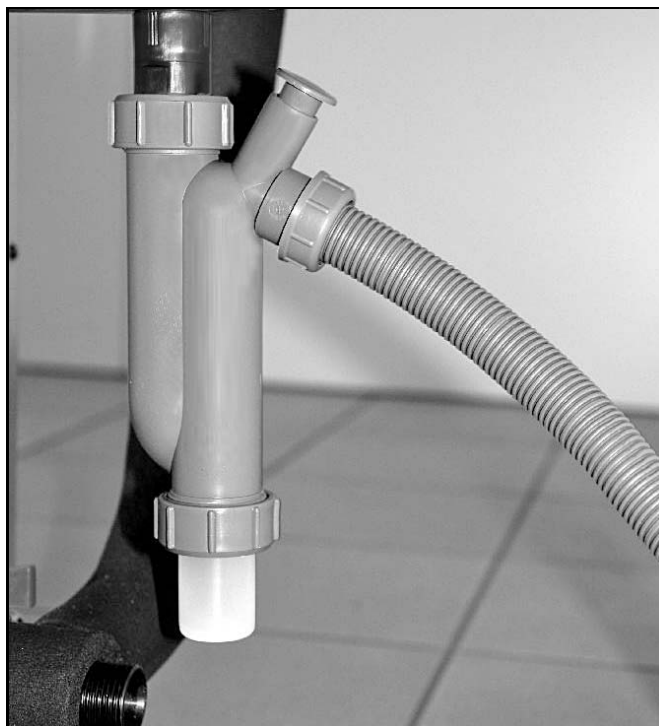
Abb. 25: Montierter Kondensatschlauch am Siphon
