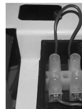
Brücke aus den Anschlussklemmen für den Speicherthermostaten entfernen. (links in der Klemmenbox)
