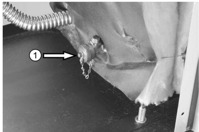
Abb. 23: Kesselfüll- und Entleerhahn ①
