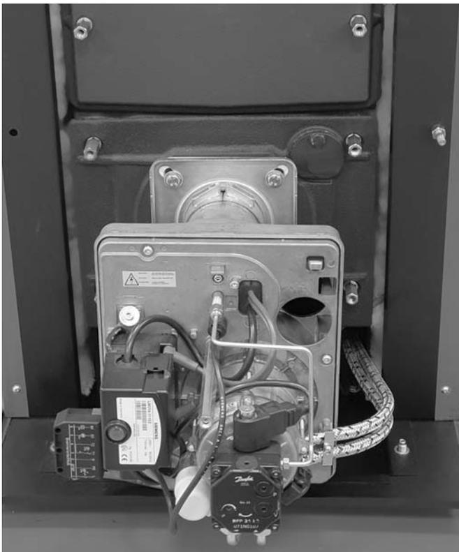
Abb. 7: Montierter Öl-Blau-Brenner
