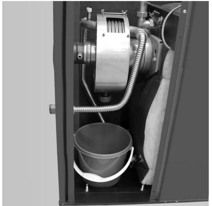
Abb. 91: Zur Reinigung vorbereiteter RWT
