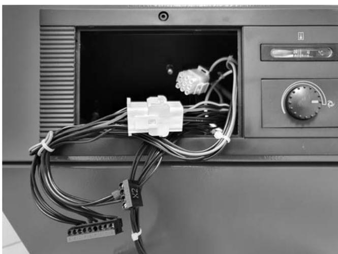
Abb. 35: Anschlussstecker für den Regler.
