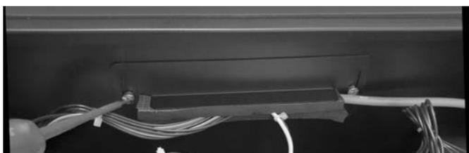
Abb. 34: Verschlossener Kabelschlitz.
