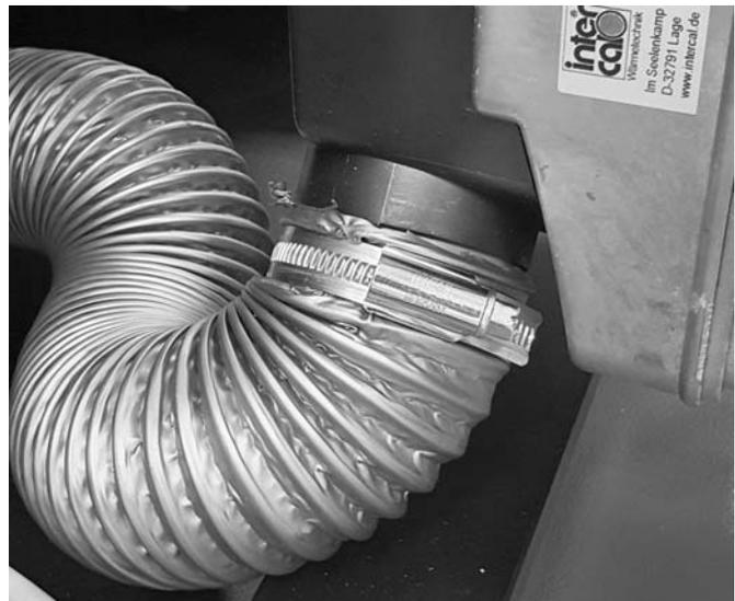
Abb. 14: Zuluftschauch am Schalldämpfer
