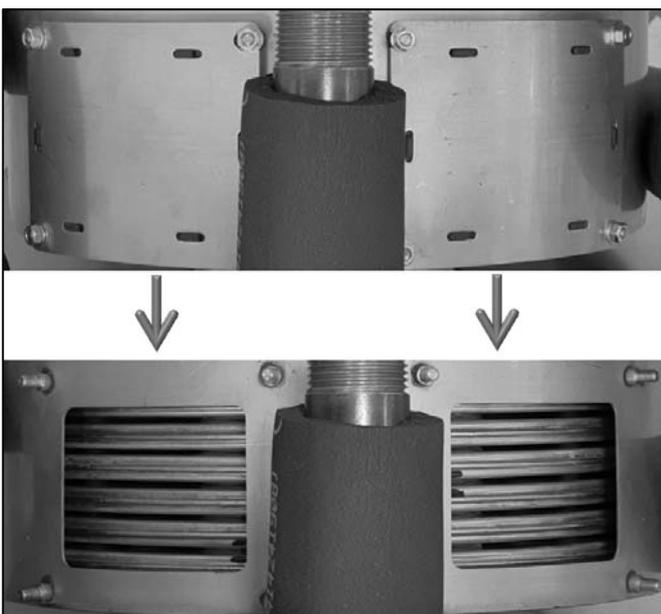
Abb. 85: Geöffneter Wärmetauscher nach Lösen der Deckel-Muttern
