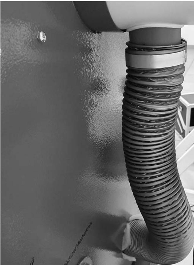
Abb. 12: Zuluftschauch am Kesselabgasanschluss
