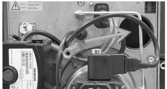
Abb. 9: Luft-Ansaugöffnung des Brenners BNR 100
