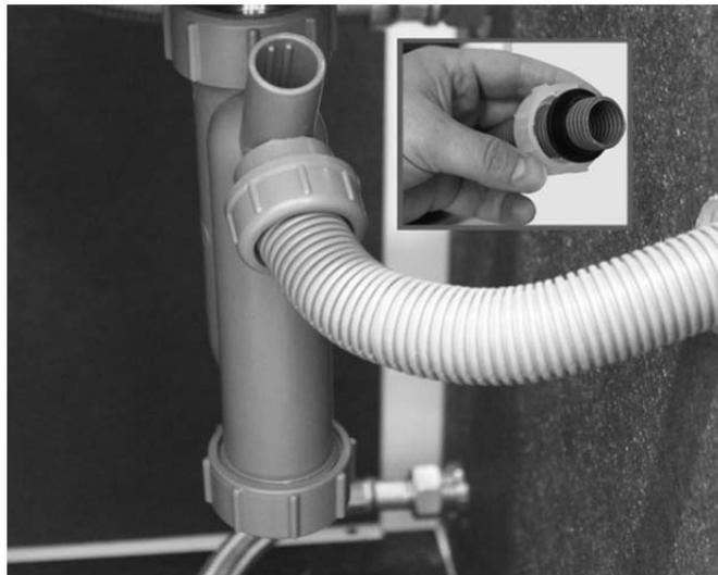
Abb. 16: Montage des Kondensatschlauchs
