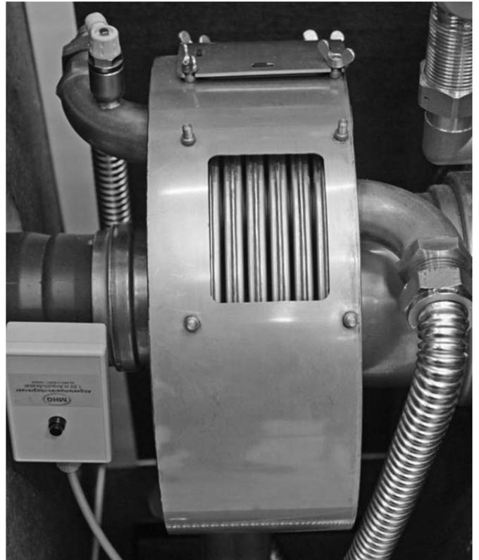
Abb. 90: Reinigungsöffnung des RWT
