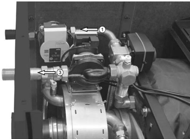
Abb. 22: Vorlauf Direktkreis ③ sowie Vorlauf Mischerkreis ① (bei Ausführung Premium)
