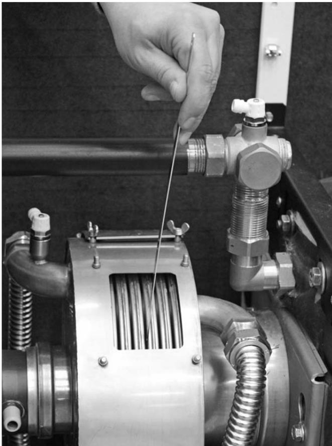
Abb. 92: Anwendung der Reinigungsklinge
