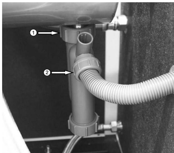
Abb. 88: Demontage des Kondensat-Siphons
