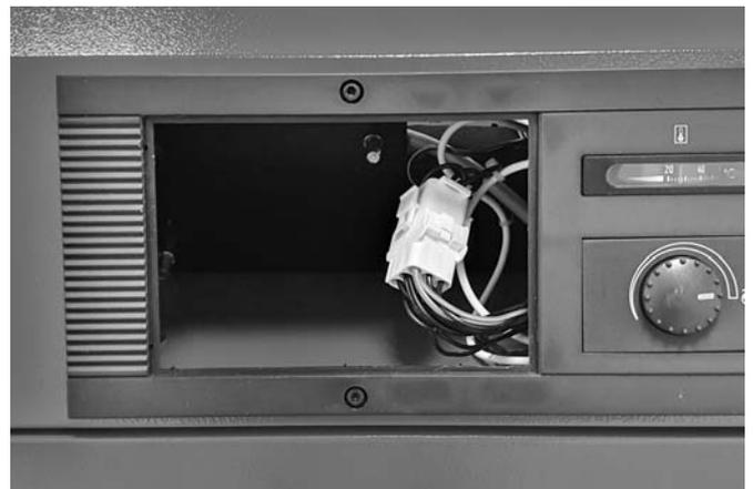
Abb. 31: Offener Reglerschacht mit Steckverbindung für den Regler-Kabelbaum.
