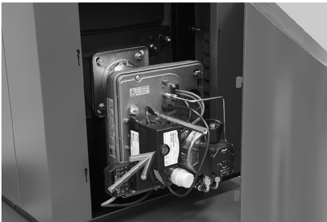
Abb. 2: Reset-Taste am Brenner BNR 100
